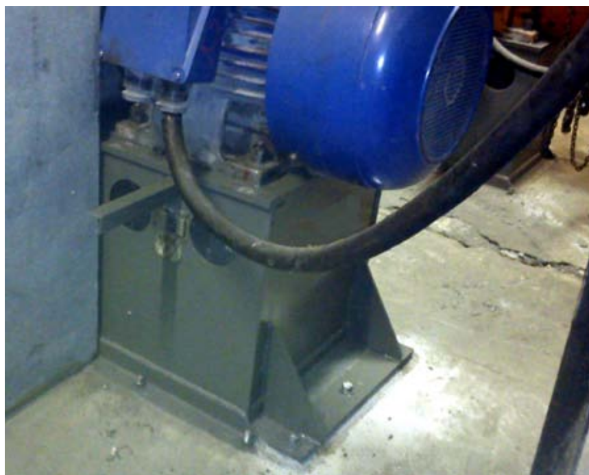
Rys. 12. Zespół wentylatora objęty badaniem po wzmocnieniu posadowienia
